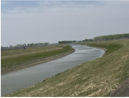
堤防边坡草皮护坡情况
