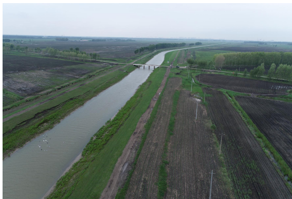
左岸堤顶路和边坡草皮护坡情况
