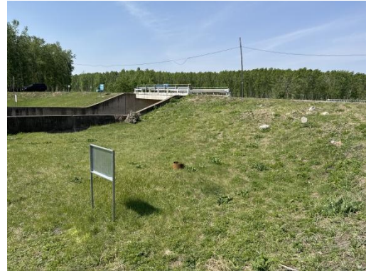
堤防边坡草皮护坡情况（临近建筑物处）
