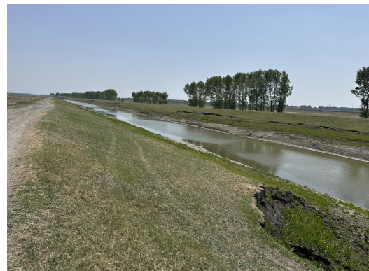
右岸堤防草皮护坡情况
